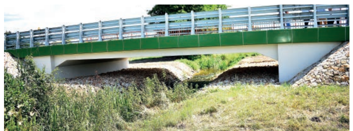
Most w Solcu Starym o długości 14 m i szerokości całkowitej 9,4 m, oddany do użytku w lipcu 2020 roku. Wartość robót to: 1 mln 147 tys. zł.
