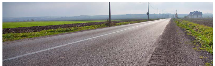
Przebudowana droga powiatowa z Wilkowej do Łubnic.
