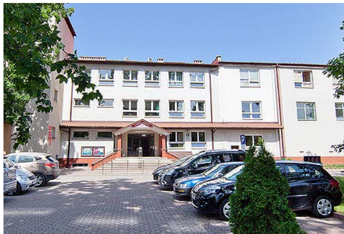
Sukcesywnie rozbudowywano i unowocześniano budynki szkolne Zespołu Szkół w Staszowie.
