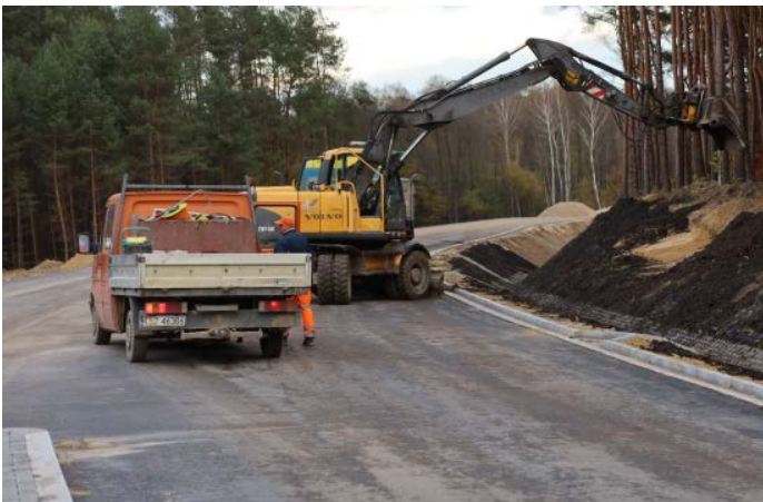
Na bieżąco trwa układanie ażurowych płyt odwodnienia, a także humusowanie skarp.
