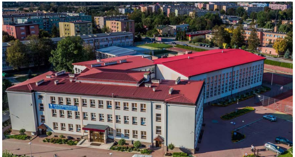
Pierwsza hala sportowa oddana do użytku w październiku 2001 roku, powstała przy Liceum Ogólnokształcącym w Staszowie.
