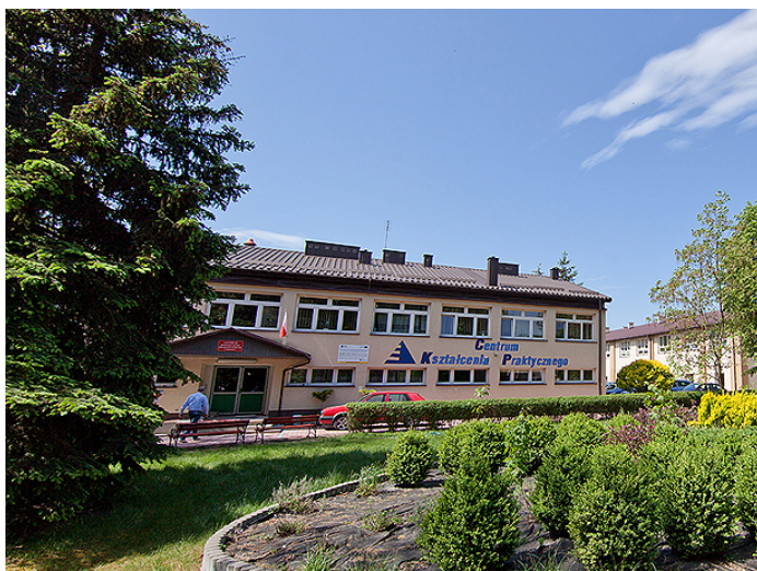
Rozbudowano i unowocześniono pracownię Centrum Kształcenia Zawodowego w Staszowie, poprzednio CKP.
