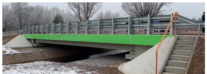
Nowy most w Podborcu o długości 15,2 m i szerokości 9,5 m oddany do użytku w grudniu 2021 roku. Całkowity koszt robót budowlanych wyniósł 1 mln 323 tys. zł.
