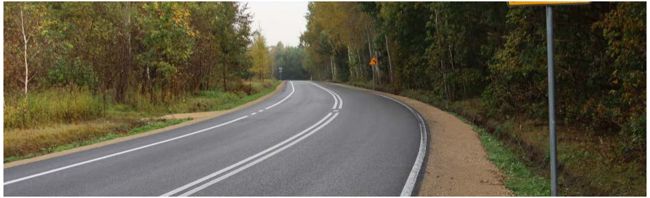
Przebudowany odcinek drogi powiatowej nr 0786T Jurkowice-Wiśniówka – odcinek od zjazdu z drogi wojewódzkiej nr 765 Chmielnik-Osiek, w kierunku Czajkowa Południowego i Smerdyny.
