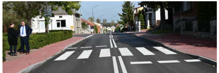
Przebudowany odcinek drogi powiatowej w Oleśnicy.
