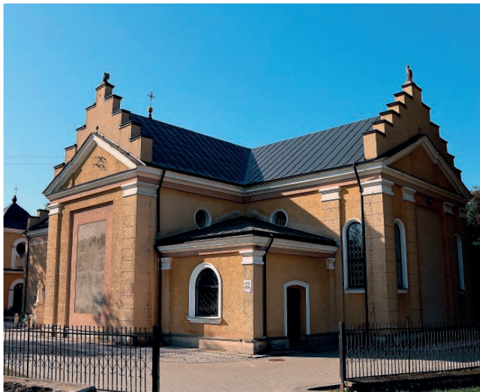
Dach kościoła pw. Świętego Michała Archanioła w Wiązownicy Kolonii.
