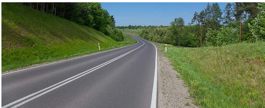
Przebudowana droga wojewódzka nr 765 Staszów-Chmielnik z obwodnicą Kurozwek, długość odcinka 34 km, wartość inwestycji zakończonej w grudniu 2012 roku 79 mln 650 tys. zł.
