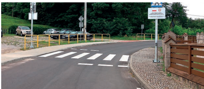
Przejście dla pieszych w ciągu drogi powiatowej nr 0813T w Niekrasowie, koszt budowy 151 tys. 516 zł. Jedno z 15 przejść jakie wybudowano w minionej kadencji.
