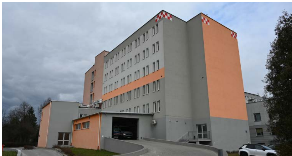
Pięciokondygnacyjny pawilon łóżkowy dobudowano do szpitala od strony południowo-zachodniej.
