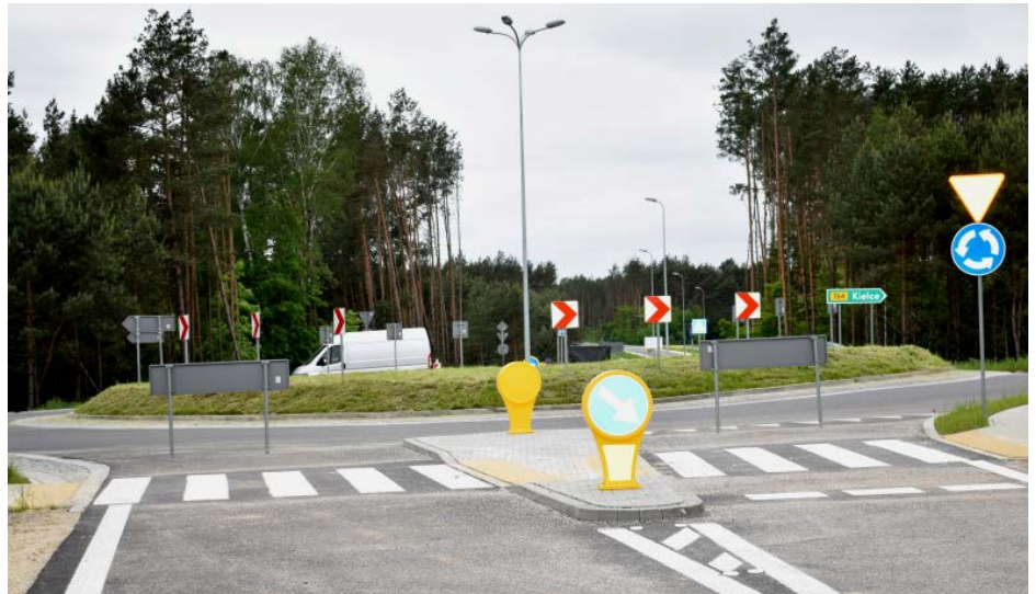
Od ronda obwodnicy na DW 764 Staszów-Raków budowany jest drugi odcinek obwodnicy w kierunku północnym do DW 757 Staszów-Opatów.
