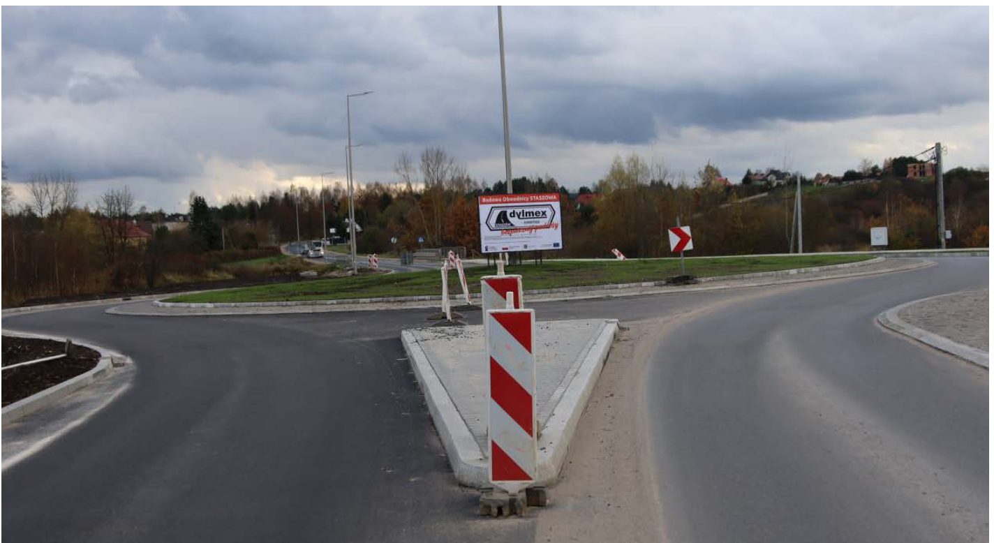
Od 5 listopada 2023 roku, na nowo pobudowanym rondzie w ciągu DW 757 Staszów-Opatów przywrócono ruch bez sygnalizacji świetlnej.
