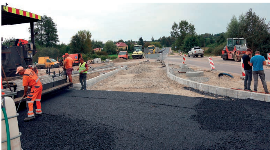
Budowa ronda na DW 757, widok w kierunku Staszowa.
