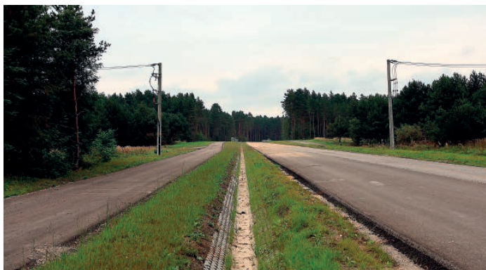
Obwodnica i droga serwisowa w budowie od strony ronda na DW 764.
