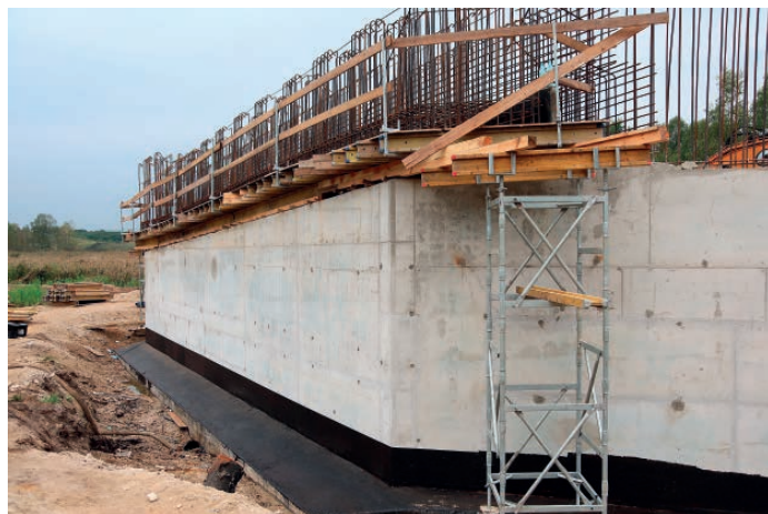
Podpora mostowa P-1 w budowie.
