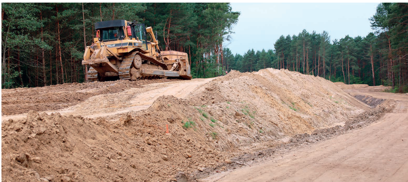
Formowanie nasypu w kierunku ronda na DW 764.
