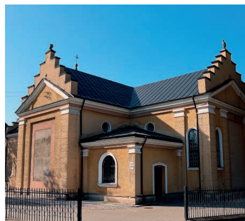
Dach kościoła pw. Świętego Michała Archanioła w Wiązownicy Kolonii.
