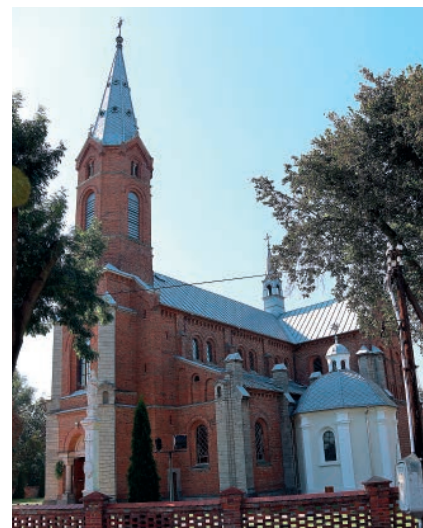
Dach kościoła pw. św. Marcina w Połańcu”.
