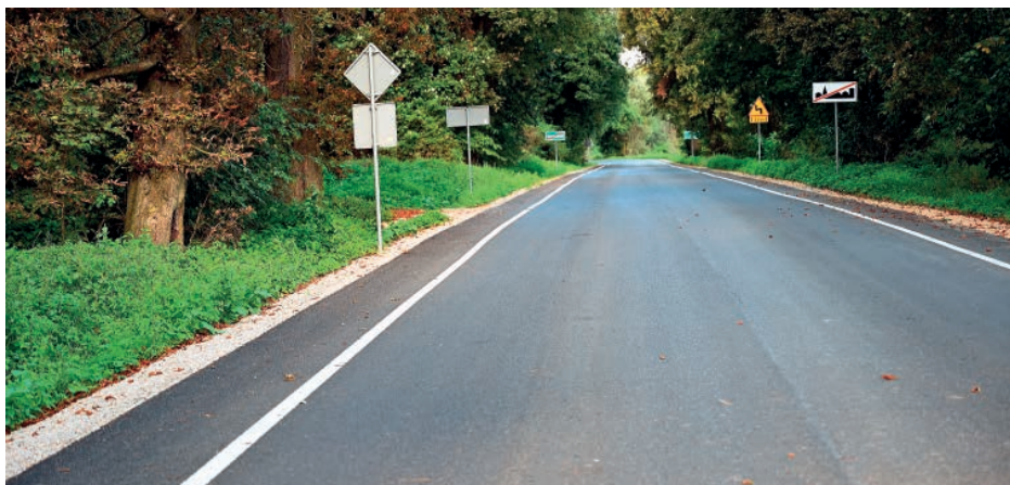
Przebudowana droga powiatowa nr 0828T Życiny – Korytnica – Kurozwęki od strony Kurozwęk.
