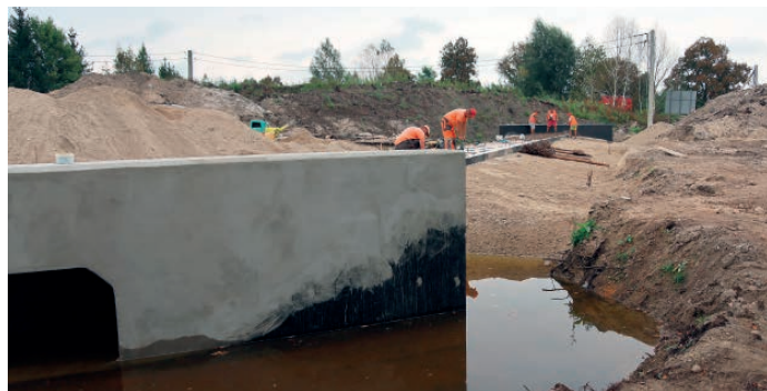
Na całej szerokości drogi powstają 2 przepusty skrzynkowe o wymiarach 150 x 100 cm umożliwiające odprowadzenie wody.
