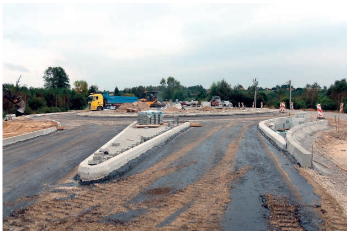
Wyjazd z ronda w budowie, w kierunku Bogorii.
