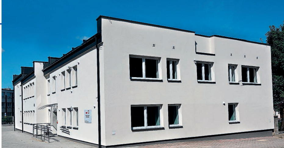
Meble zostaną zakupione na wyposażenie zrewitalizowanego budynku po dawnej Komendzie Powiatowej Policji w Staszowie. Oficjalne przekazanie budynku do użytku m.in. przez instytucje powiatowe nastąpi 6 października br.
