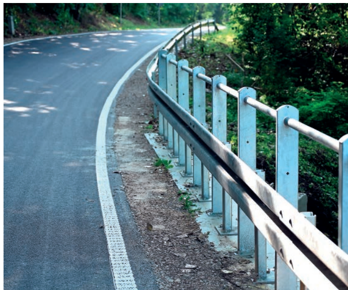
W Szydłowie przebudowano odcinek o długości 995 m drogi powiatowej w kierunku Brzeziny.
