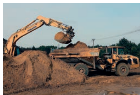
Transport piachu pod stabilizację ciągu głównego i podbudowę dla nawierzchni asfaltowej.
