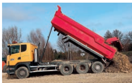
Budowa platformy pod palownicę od strony DW 757. Kamień do budowy pochodzi z Kopalni w Smerdylinie.
