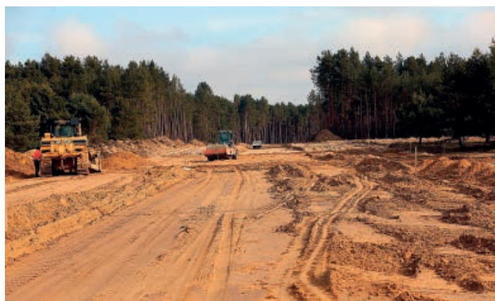
Oprócz profilowania głównego koryta drogi, profilowane są także koryta dróg serwisowych.
