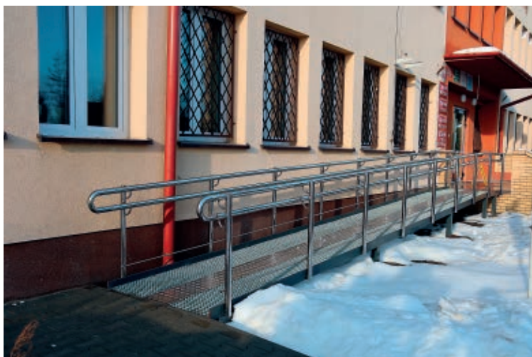
Przy budynku Urzędu Gminy w Rytwianach wybudowano podjazd dla osób niepełnosprawnych, zabezpieczony balustradą ze stali nierdzewnej.
