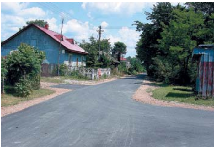
Nowa nawierzchnia drogi powiatowej nr 0842T w Grabowej.
