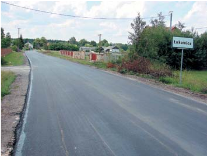
Odnowa nawierzchni drogi nr 0785T w Łukawicy - w trakcie realizacji.
